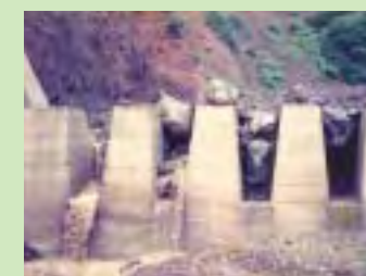
金山沢2号砂防えん堤(長野県) Kaneyamasawa No.2 Sabo dam (Nagano Prefecture)
