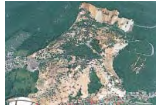
地附山の大规模地すべり (昭和60年7月、長野市) Large-scale landslide on Mt. Jizuki (Nagano City, July 1985)
