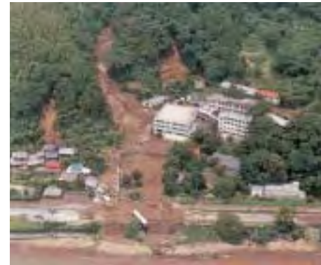
梅雨前線豪雨によるがけ崩れ (平成5年8月6日、鹿児島県鹿児島市花倉地区) Slope failure due to torrential rainfall of the Bai-u front (Hanakura Area, Kagoshima City, Kagoshima Prefecture August 6, 1993).
