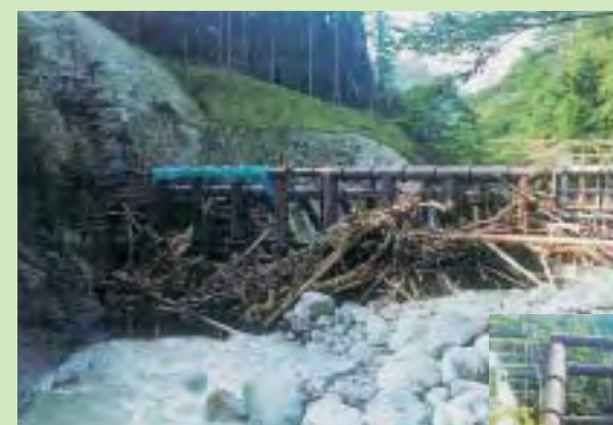
長野県梨子野川流域で平成12年9月集中豪雨により土石流が発生。既設の砂防えん堤が流下土石を捕捉しました。 A debris flow was caused along the Nashikono river in Nagano prefecture in September 2000. The existing sabo dam captured debris flows.
