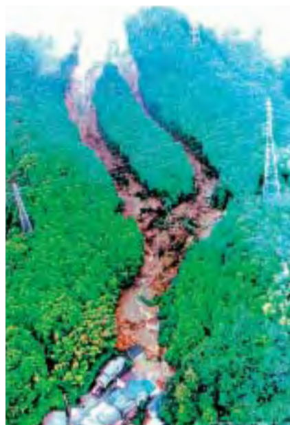
豪雨により土石流が発生した高知市西町(平成10年9月25日) A debris flow caused by a torrential rainfall in Nishi-machi, Kochi City (September 25, 1998)
