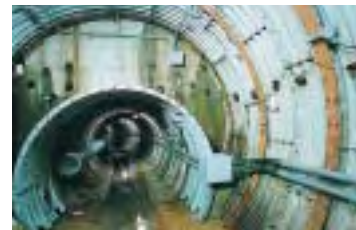
排水トンネル工 Drainage tunnel works
