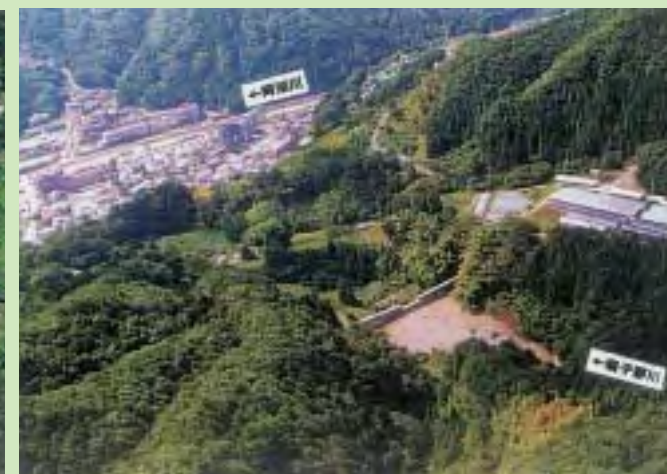
長野県梨子野川流域で平成12年9月集中豪雨により土石流が発生。既設の砂防えん堤が流下土石を捕捉しました。 A debris flow was caused along the Nashikono river in Nagano prefecture in September 2000. The existing sabo dam captured debris flows.
