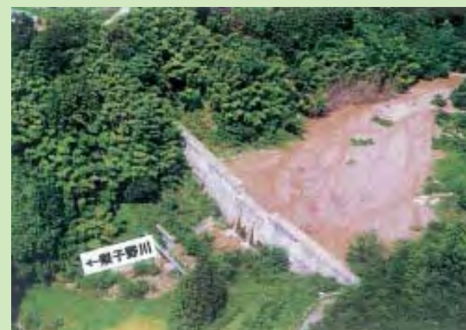
長野県梨子野川流域で平成12年9月集中豪雨により土石流が発生。既設の砂防えん堤が流下土石を捕捉しました。 A debris flow was caused along the Nashikono river in Nagano prefecture in September 2000. The existing sabo dam captured debris flows.
