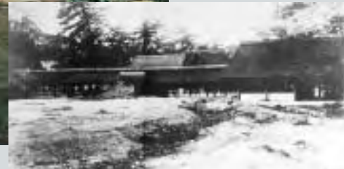
枕崎台風により紅葉谷川で発生した土石流で被災した厳島神社の神殿 (昭和20年9月) Itsukushima shrine damaged by a debris flow from Momijidani River caused by Makurasaki typhoon (Sep. 1945).
